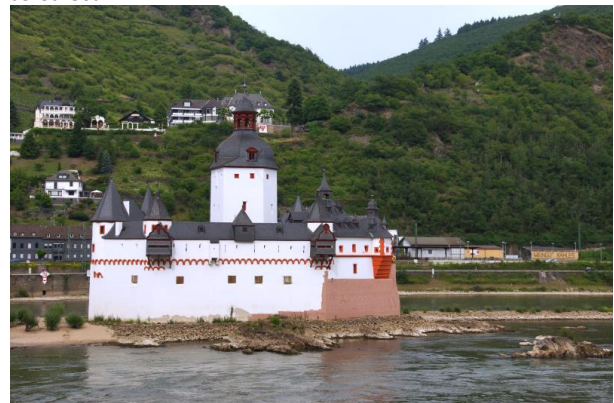
Die Zollstation „Die Pfalz“ im Strom nahe Oberwesel
